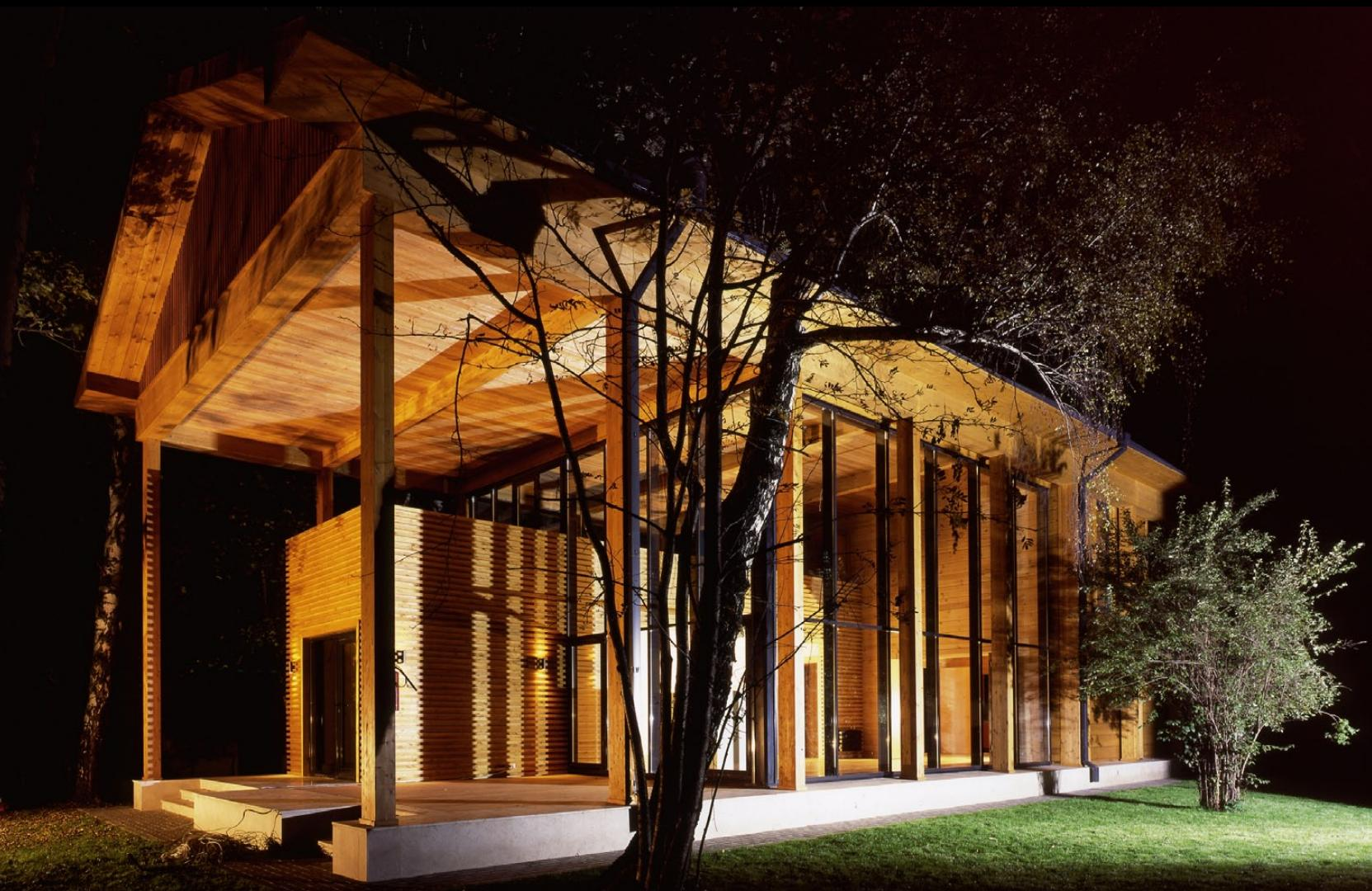
Конструктивная схема дома состоит из двух частей: в двухэтажном срубе из бруса размером 270 x 200 мм находятся жилые комнаты и кухня, по периметру всего дома с шагом 3 м стоят колонны из бруса, автономно несущие кровлю. Это позволяет витражно остеклить двусветную гостиную в западной части дома.
