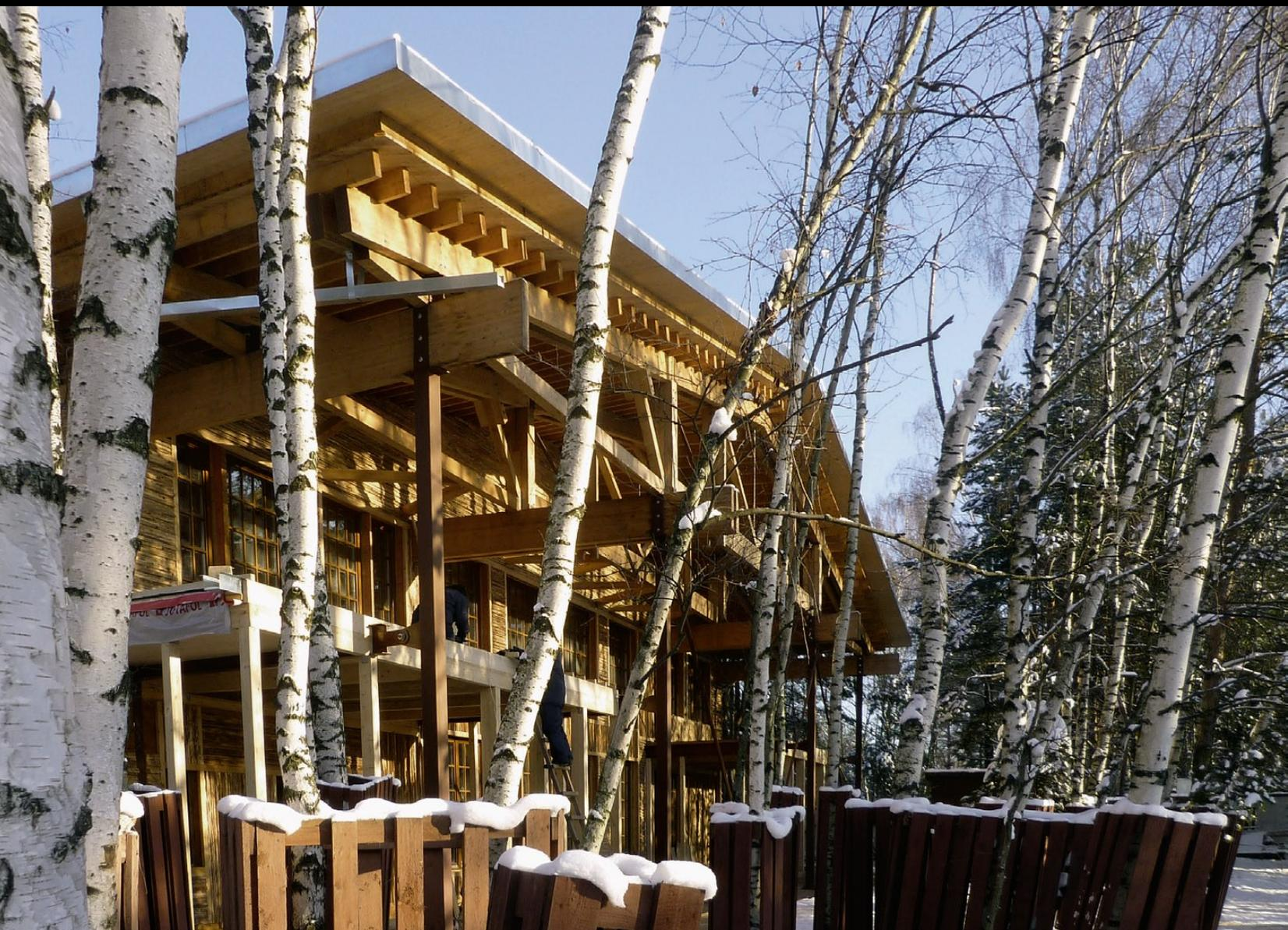
Дом расположен на берегу Клязьминского водохранилища. Трапециевидный в плане, своей широкой частью он ориентирован на воду и перекрыт значительно выступающей за его пределы кровлей. Фасад «неаккуратно» отделан горбылем (отбросами пиломатериала), закрепленным заплатами то горизонтально, то вертикально. Шершавая, тактильная фактура грубой случайности горбыля на стенах контрастирует с точно рассчитанными обнаженными деревянными фермами и прогонами кровли, перекрывающими двенадцатиметровый пролет.
