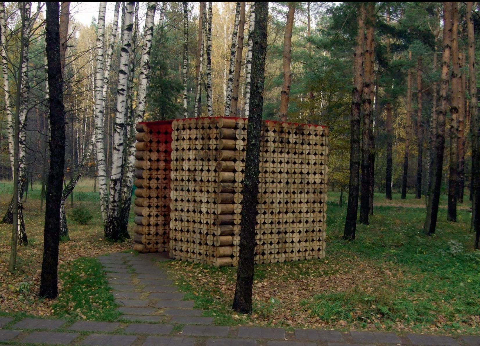
На проектируемом участке разравнивается песок и укладывается тротуарная плитка. Конструкции выполнены из цилиндрованных деревянных брусков, скрепленных между собой стальными скобами.
