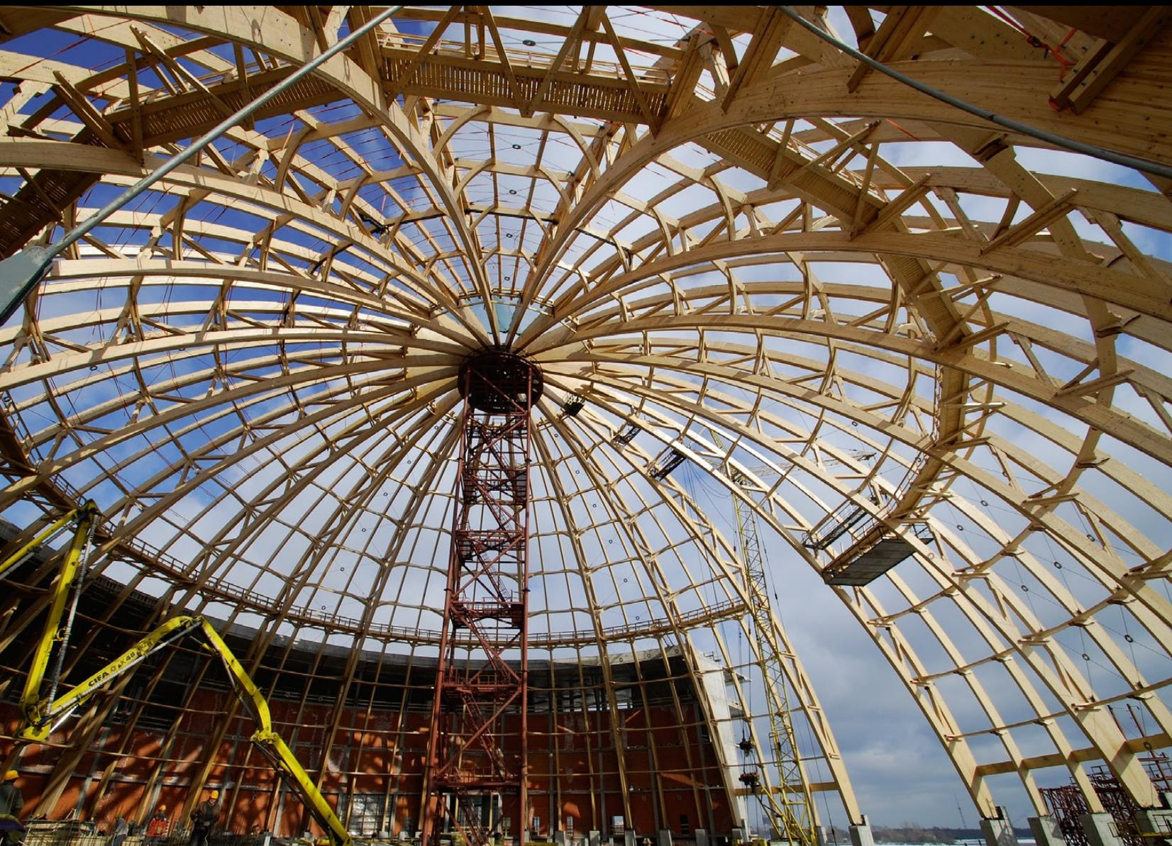
Купол аквапарка – самый большой в России пролет из деревянных конструкций: его диаметр – 90 м. Но, кроме размеров, важны еще два обстоятельства. Во-первых, это не просто деревянная крыша (как обычно используют КДК), а гигантская беседка: фермы купола доходят до земли. Во-вторых, это редкий случай, когда деревянный конструктив не спрятан за обшивкой. Купол накрыт полупрозрачным пластиком-«подушкой»: снаружи видны конструкции, изнутри – облака.
