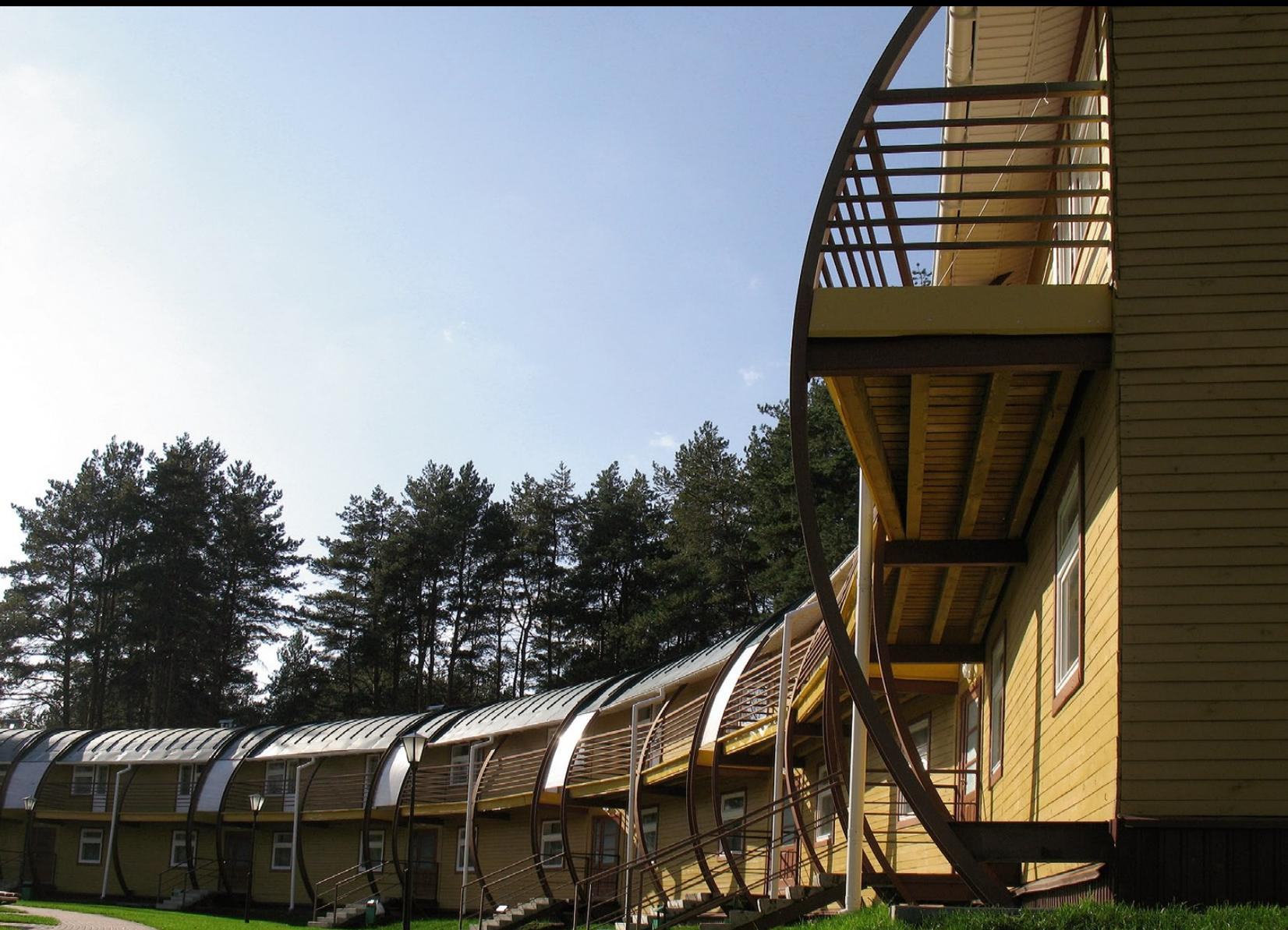
Гостиница – часть проекта реконструкции старой базы отдыха Выксунского металлургического комбината. Ее вытянутая форма напоминает змею, ползущую между деревьями. На самом деле здание состоит из трех отрезков – по 40 номеров эконом-класса в каждом. В подземной части подведены коммуникации. Поперечные ребра жесткости – металлические кольца, на которые опираются деревянные перекрытия и кровля. Наружные стены из деревянного каркаса, утепленного и обшитого снаружи и изнутри доской.
