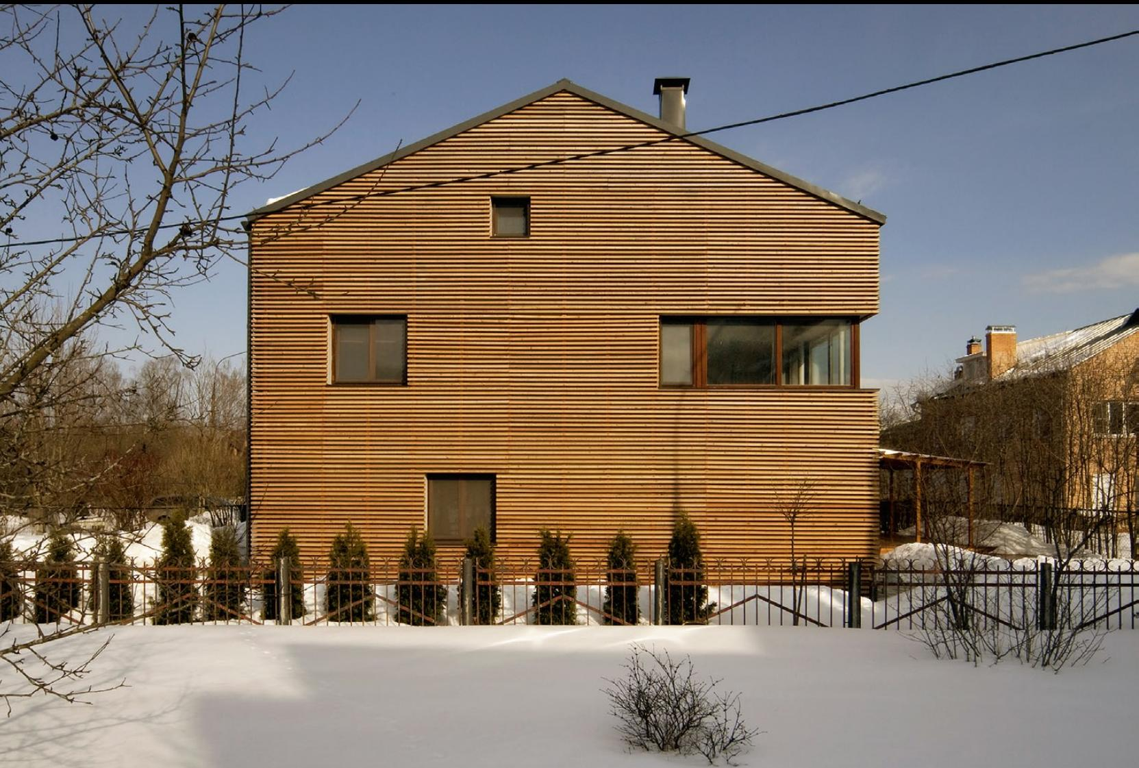
В процессе реконструкции жилой дом был надстроен вторым и мансардным этажами. Существующие и новые части здания объединены навесным фасадом из бруска лиственницы. В надстроенной части под традиционной двускатной кровлей образовано внутреннее двухсветное пространство с антресолью – кабинетом, организующее вокруг себя жилую зону. На мансарде расположена приватная зона спален.
